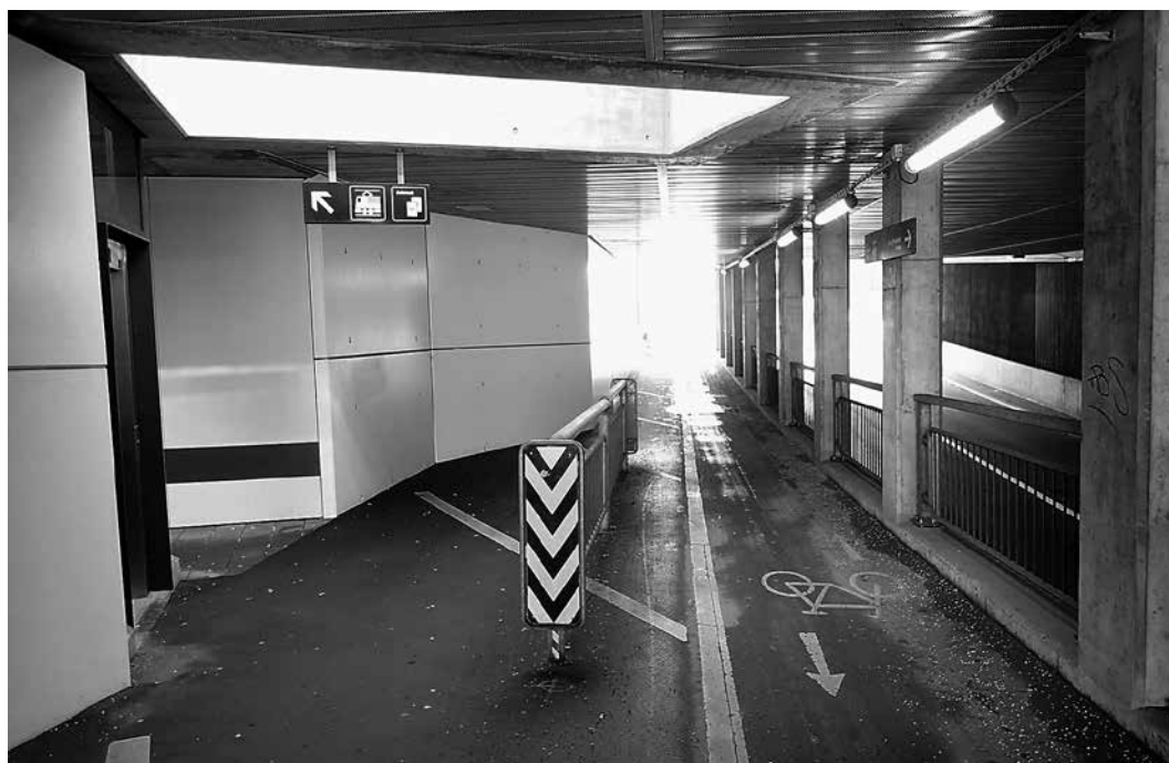
Wegen zwei seitlich nicht einsehbaren Zugängen, mussten bei der, ebenfalls als eine der Ersatzrouten angedachten, Unterführung Kantonsstrasse Absperrgitter zur Trennung von Fussgängern und Radfahrern montiert werden. Nur stellen diese jetzt eine grosse Gefahrenquelle dar. Der markierte Radweg ist nur noch 1.47m breit.
